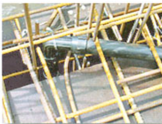
การติดตั้งบริเวณพื้นคอนกรีตเสริมเหล็ก
