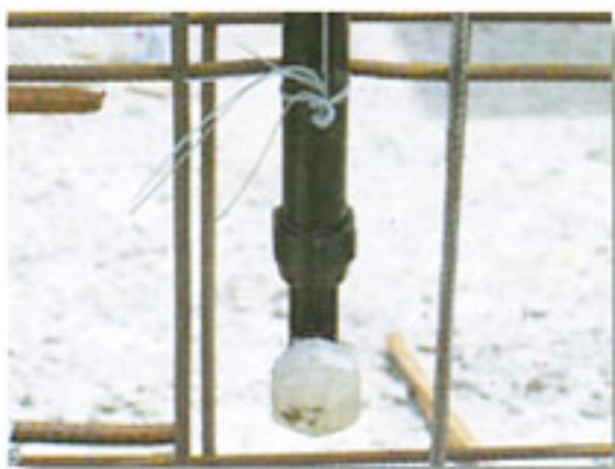
การติดตั้งบริเวณผนังคอนกรีตเสริมเหล็ก
