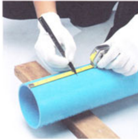
2. กรณีที่ต้องตัดท่อ ให้ทำเครื่องหมายระยะที่ต้องการตัด ให้ได้ฉากกับแนวแกนท่อ
