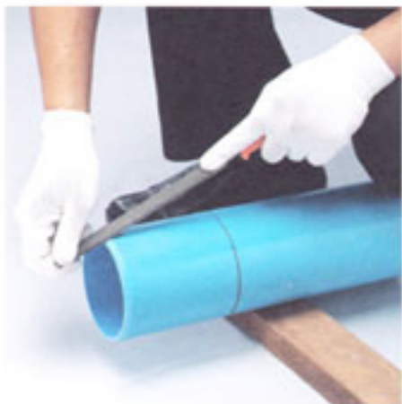
4. ใช้ตะไบละเอียดแต่งรอยตัดให้เรียบและลบมุมปลายท่อโดยรอบให้มีความลาดเอียงประมาณ 15°
