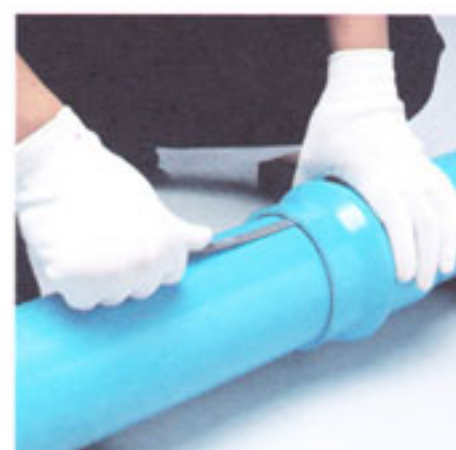
9. เมื่อท่อถูกต่อเข้าด้วยกันแล้ว ตรวจสอบว่าท่อต่อถึงบริเวณที่ขีดเครื่องหมายไว้หรือไม่ ใช้ Check Gauge ตรวจสอบว่าแหวนยางอยู่ในตำแหน่งที่ถูกต้องหรือไม่
