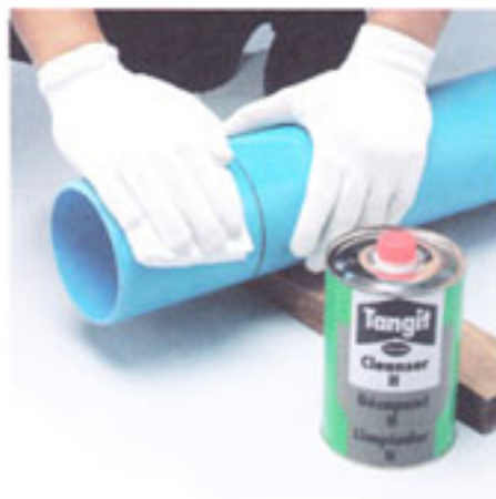
5. ใช้ผ้าทำความสะอาดท่อพีวีซี "ตราช้าง" ทำความสะอาดปลายท่อที่จะสวมใส่และบริเวณแนวร่องแหวนยาง
