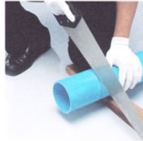
3. ตัดท่อด้วยเลื่อยช่างไม้หรือเลื่อยตัดโลหะ หรือ Tubing Cutting
