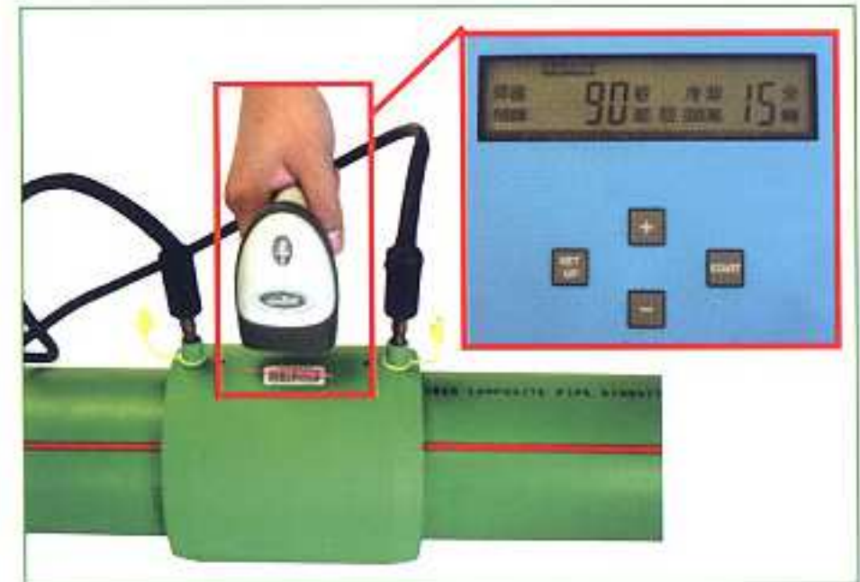
6 นำหัวอ่านบาร์โค้ดถึงที่บาร์โค้ด เวลาในการให้ความร้อน (Fusion) และเวลาในการเย็นตัว (Cooling) จะปรากฏที่จอแสดงพล็อตโดยอัตโนมัติ จากนั้นกดปุ่ม START เริ่มทำงาน
