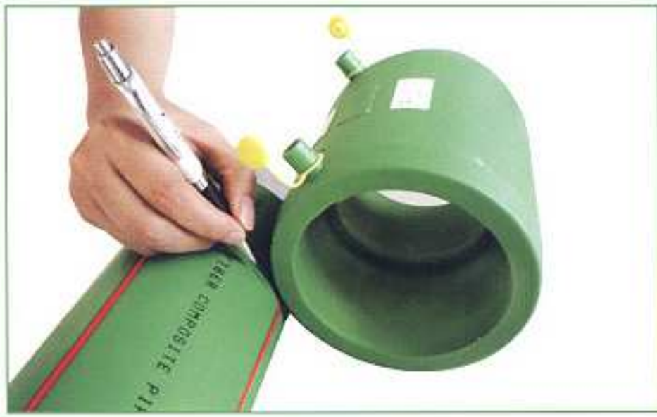
1 กำหนดความลึกในการเชื่อมโดยการวัดระยะจากข้อต่อ
